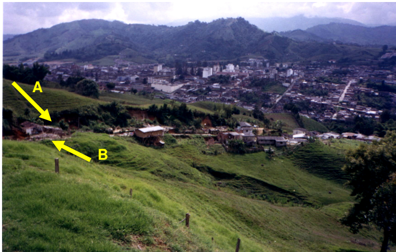
Fotografía 5. Sector del Barrio San Bernardino afectado por movimientos en masa en los taludes de la parte posterior de las viviendas. La flecha A indica la posición de los taludes y la flecha B la posición de las viviendas.
