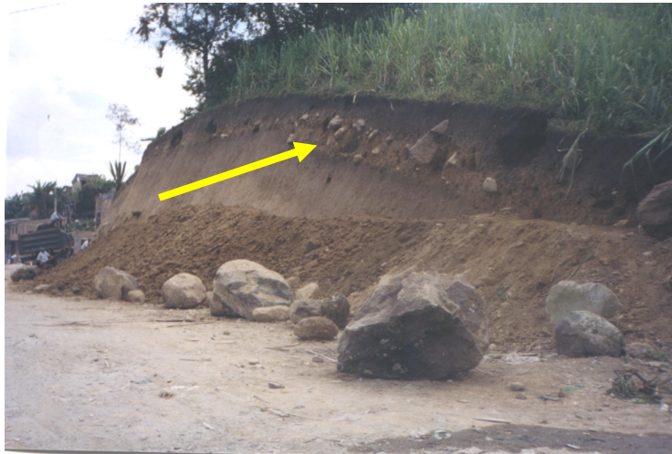
Fotografía 3. Depósito de flujos de escombros. Localizados en la antigua banca del ferrocarril al suroriente del casco urbano. La flecha indica su posición.
